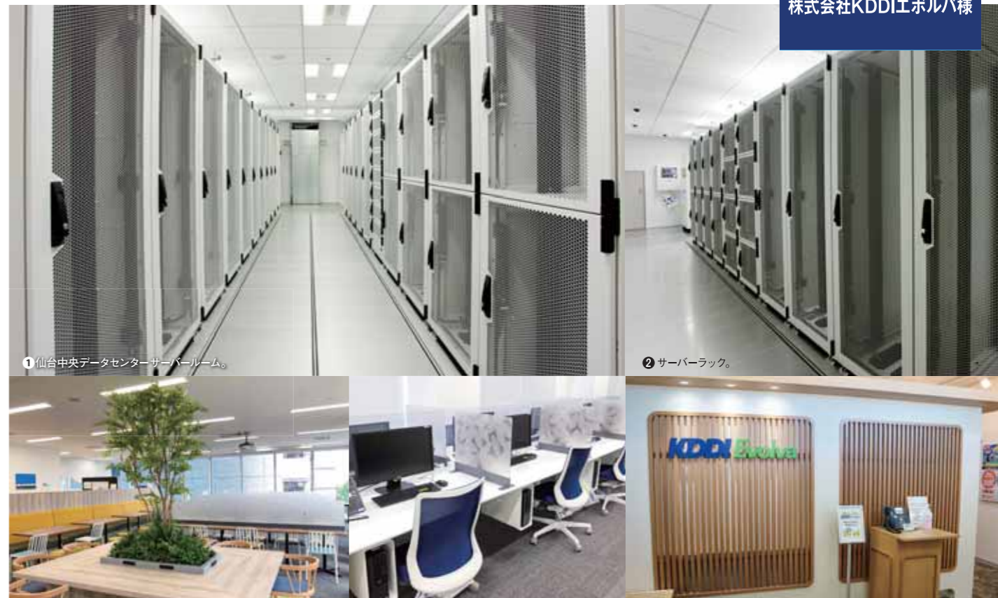
① 仙台中央データセンターサーバールーム。 ② サーバーラック。 ③ 9月開所の「宮城野センター」マルシェをイメージした休憩室。 ④ 使い心地と安全衛生環境を共存させたオフィス。 ⑤ 仙台エリアBPO・コンタクトセンター エントランス。
