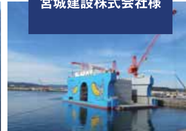
ケーソン製作用フローティングドック
