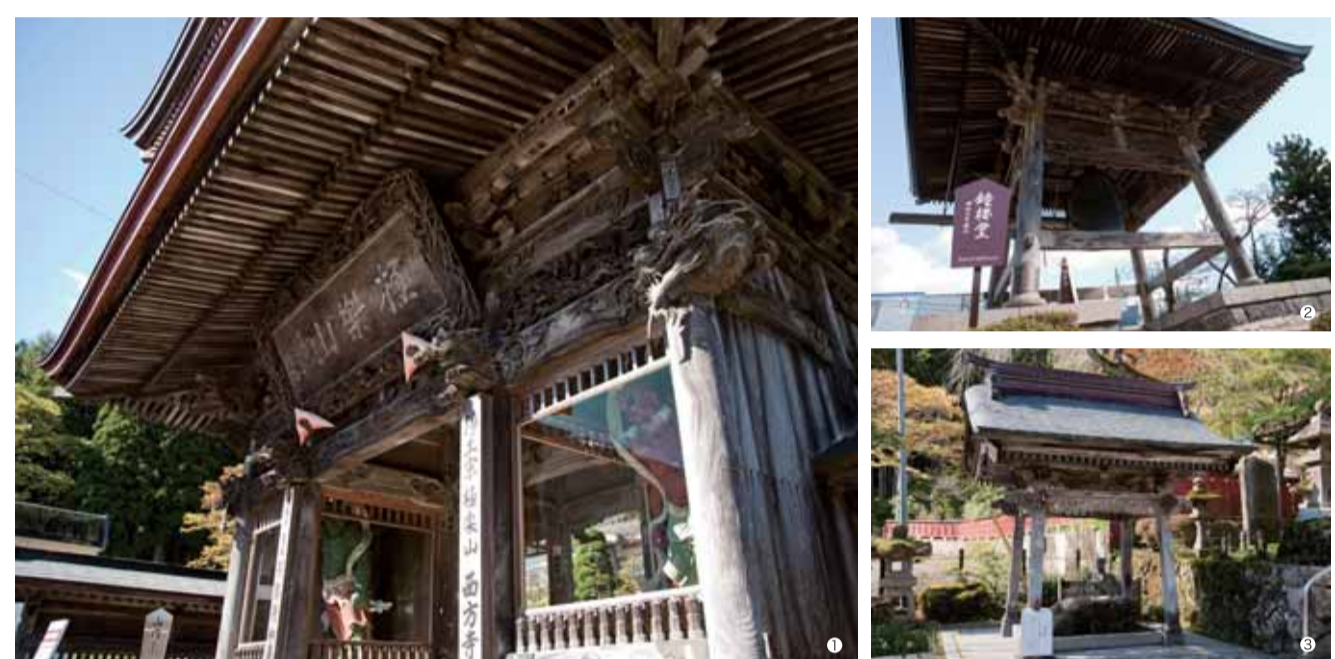
①1932年に気仙大工により建立された西方寺山門は、精密な彫刻と両脇の仁王像が印象的です。貞能堂、鐘樓堂、 手水舎とともに仙台市の登録有形文化財に指定されています。 ②③1932年建立の鐘樓堂と、その翌年に建立された手水舎。
