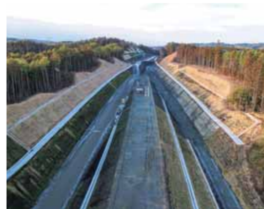
岩手県野田村 三陸沿岸道路関連工事
