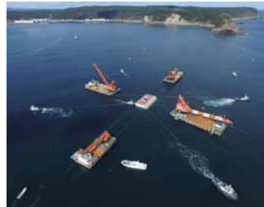
岩手県久慈市 久慈港湾口防波堤工事
