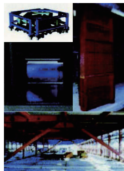
写真2: 制震装置(ATMD)／制震壁／制震ブレース／制震間柱
